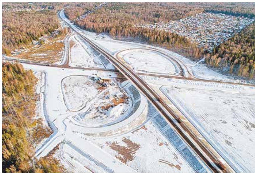
Строительство развязки на Центральной кольцевой автомобильной дороге (5-й пусковой комплекс)
