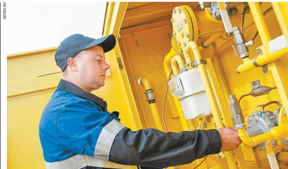
Ввод в промышленную эксплуатацию газопровода в поселки Озерки Заводуковского района Тюменской области
